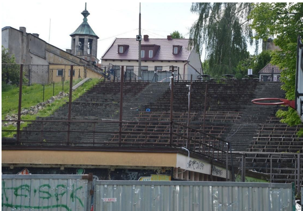
Zdjęcie 2 – Amfiteatr miejski przed modernizacją.
