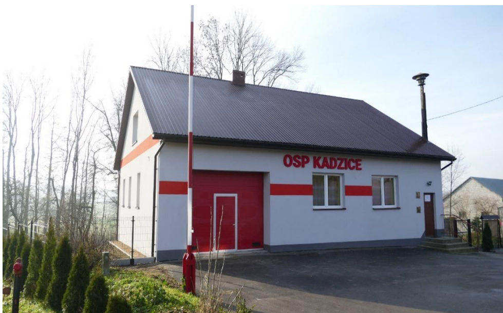
Zdjęcie 11 – Front budynku OSP w Kadzicach po wykonaniu termomodernizacji.
