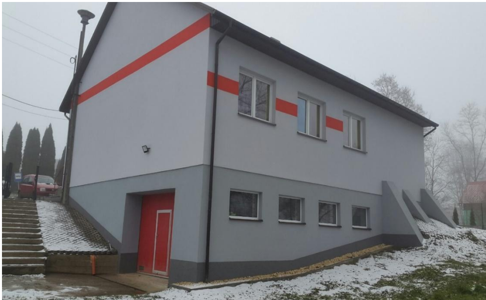
Zdjęcie 10- Budynek OSP Kadzice po wykonanej termomodernizacji.
