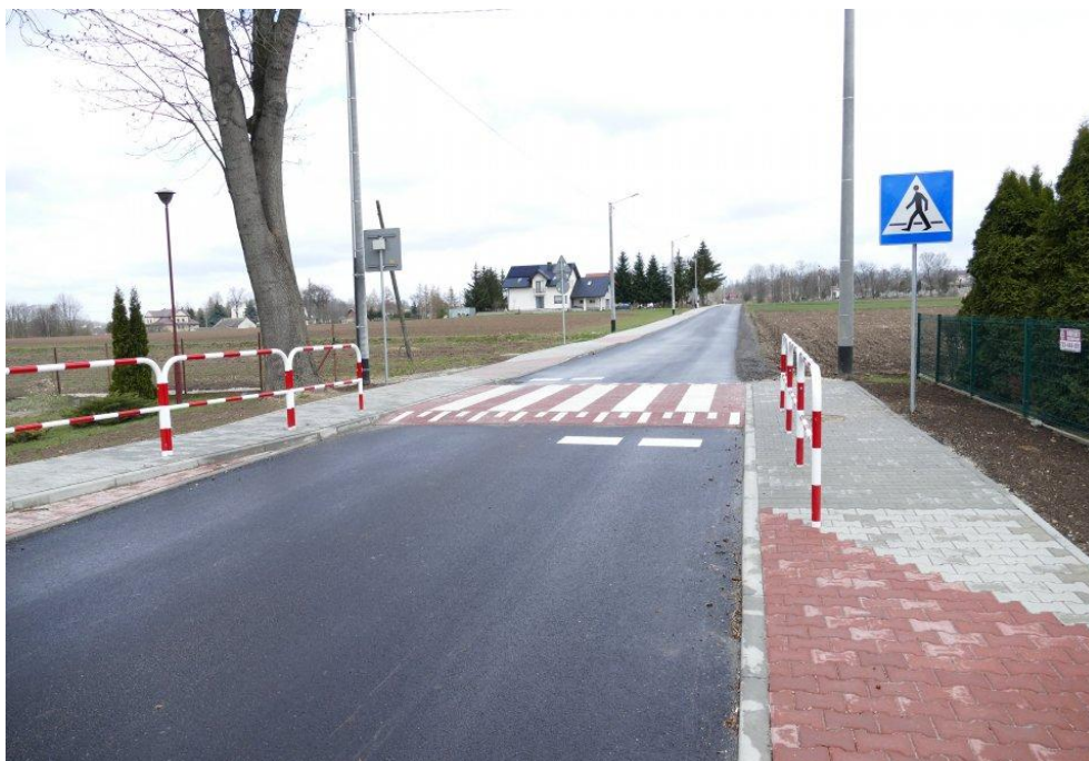
Zdjęcie 5- Droga gminna nr 160259K relacji Kościelec-Mysławczyce – po modernizacji
